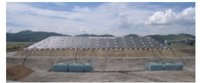
図3 実験に用いたライシメータの全景
