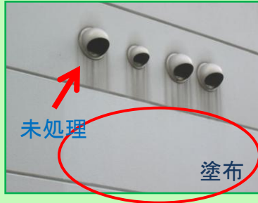
チタニア溶液を塗布した外壁 (塗布した部分の汚れが少ない)
