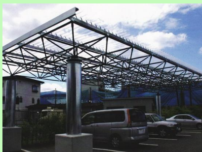
試験的に組み立てられた本構法による立体トラス
