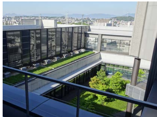
中央図書館棟屋上緑化
